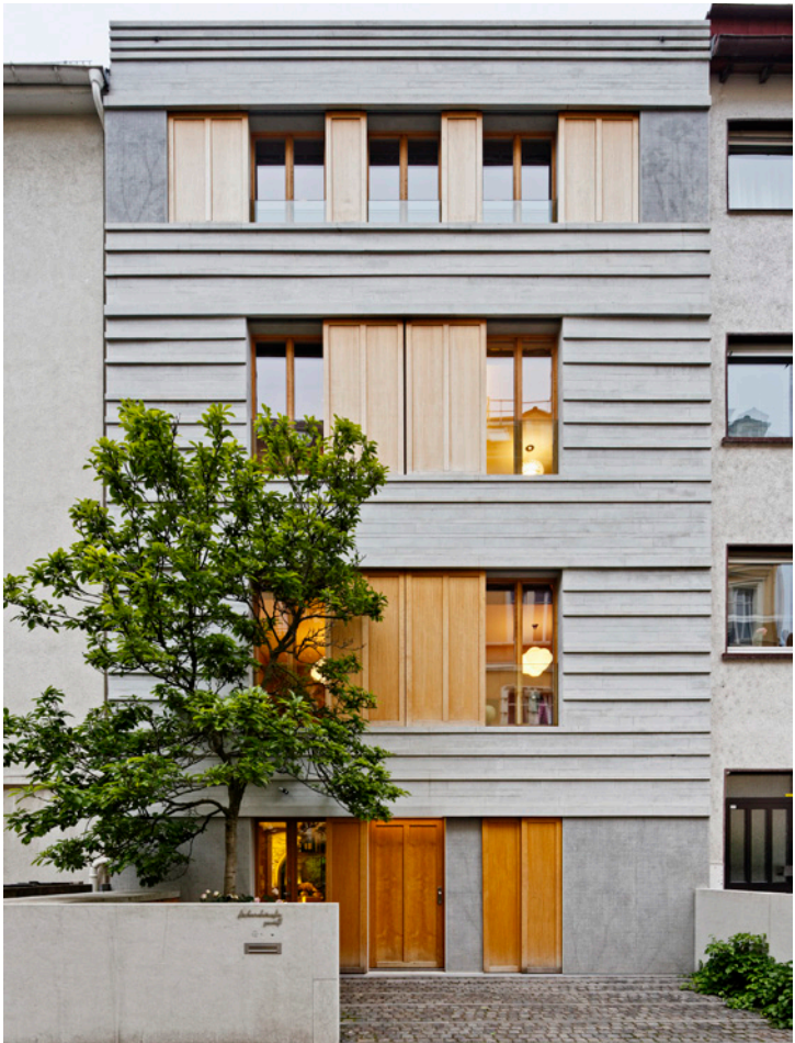
Schöner Schwan Früher galt Haus Nr. 12 als das „hässliche Entlein“ der Fichardstraße. Heute überzeugt die Straßenfront mit Eiche und feinem Pünktchenraaster. An der Rückseite (links) wurde ein zweigeschossiger Wintergarten angefügt.
